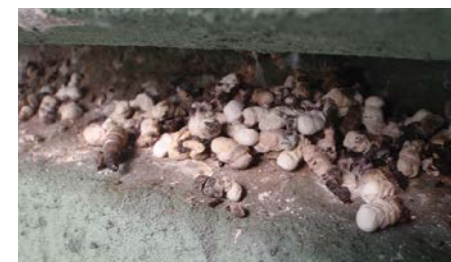
Trus dážďovníkov pri alebo pod hniezdiskom je vhodnou pomôckou na zisťovanie prítomnosti a hniezdenia.
