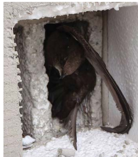
Uväznený dážďovník na hniezde, ktorý uhynul pod izolačnou vrstvou polysterénu v špajzovom vetracom otvore.
