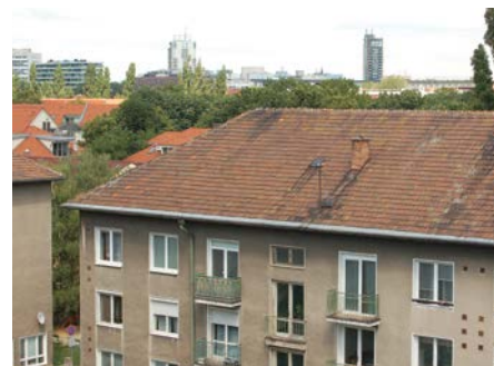
Sedlové strechy využívajú dážďovníky na hniezdenie v podkrovných častiach. Do podkrovia vletujú cez niekoľko cm široké medzery za odkvapovým žlabom.
