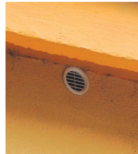
Vetrací otvor v atikovej časti strechy uzavretý mriežkou s lamelami a siečkou bráni priletu vtákom a netopierom do dutiny.
