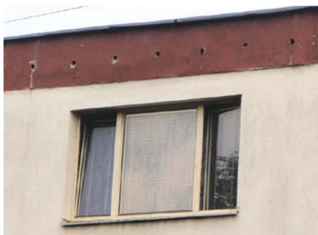
Hniezdisko dážďovníka obyčajného v atikových otvoroch kruhového tvaru s priemerom 50 až 75 mm.
