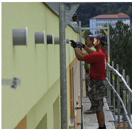
Osádzanie upravených mriežok na vetracie otvory.
