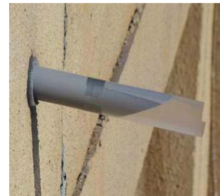
Novodurová rúrka umiestnená na miesto vedúce k dutine, odkiaľ netopiere vyletujú von. Ostatné možné otvory je nutné uzavrieť, tak aby zostal len jeden možný východ a netopiere sa nemohli vrátiť späť tým otvorom. Hladký povrch rúrky a jej skosenie a fólia na konci im znemožňujú opätovný návrat do úkrytu. Dôležitý je dostatočný vnútorný priemer rúrky.
