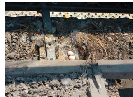
Odkryté hniezdisko dážďovníkov počas rekonštrukcie sedlovej strechy. Hniezda sú pod oplechovaním alebo pod prvým radom škridiel. Dážďovníky k hniezdam vletujú cez medzeru za odkvapovým žlabom.
